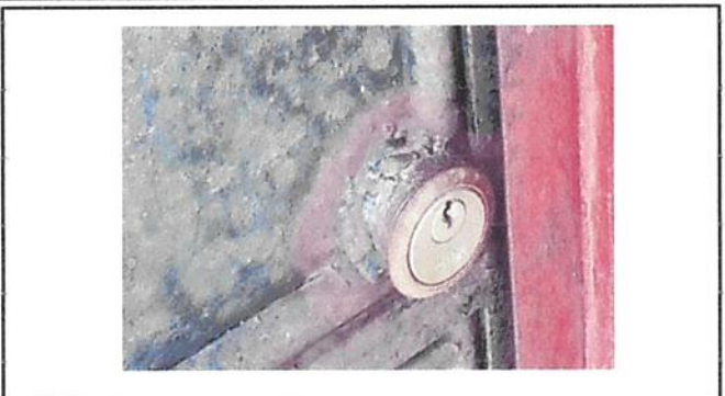
Foto 2: sustitución de chapas en puertas
