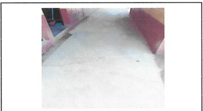
Foto 4: reparación de piso de cemento de torta concreto
